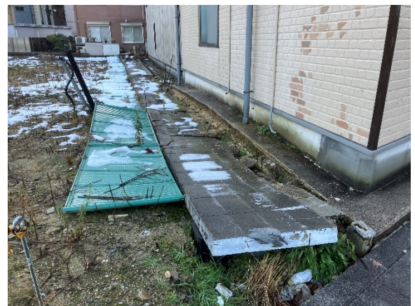
七尾市内にて。倒れたままのブロック塀
