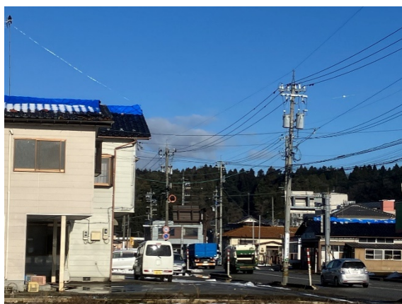
穴水町内の様子。ブルーシートのある家屋が点在している
