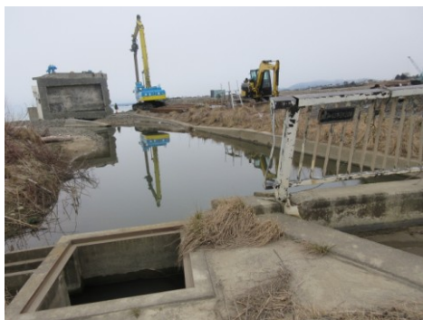
工事中の堤防
